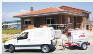
TRABAJOS EN CONSTRUCCIÓN.
